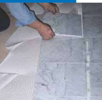
Pose de marbre de Carrare sur support bois avec Keralastic blanc
