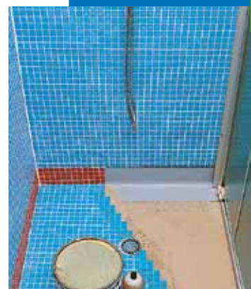
Pose dans une douche préfabriquée
