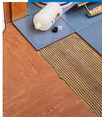
Pose sur ancien revêtements en PVC
